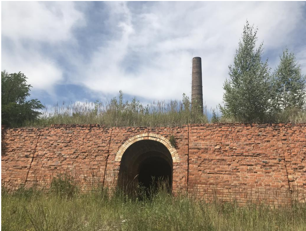
Fot. 1 Istniejąca zabudowłą – stara cegielnia
